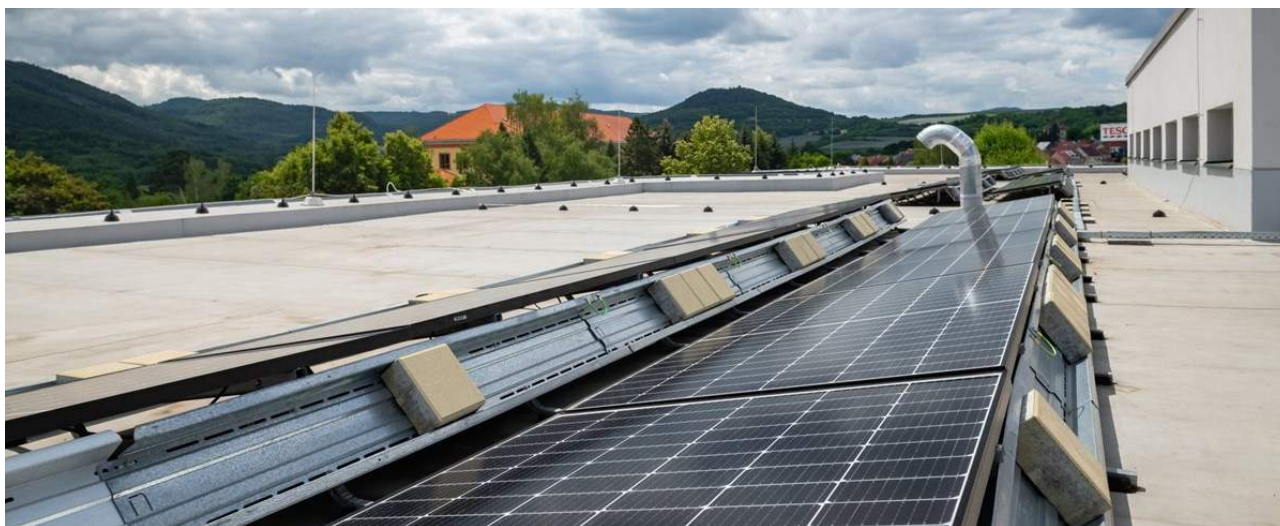
Obr. 79: Strešná fotovoltaiická elektráreň (KC Klášterec nad Ohří), zdroj: Adapterra Awards - Nadace Partnerství (Vojta Herout)
